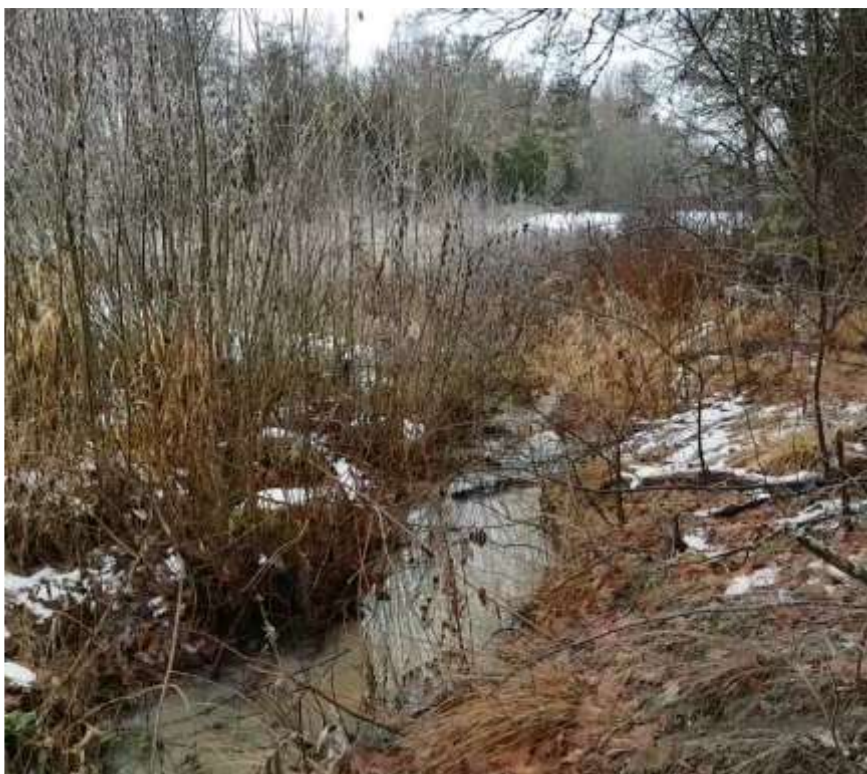
Figur 1. Diket där bräddutlopp från PS1 går ut.
